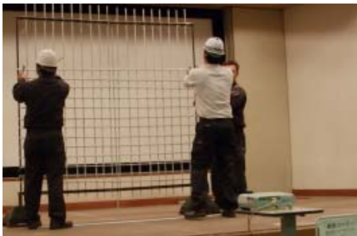
鉄筋組み立て実演
