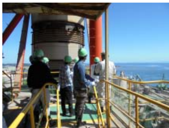
写真 - 2 プレヒータータワー
