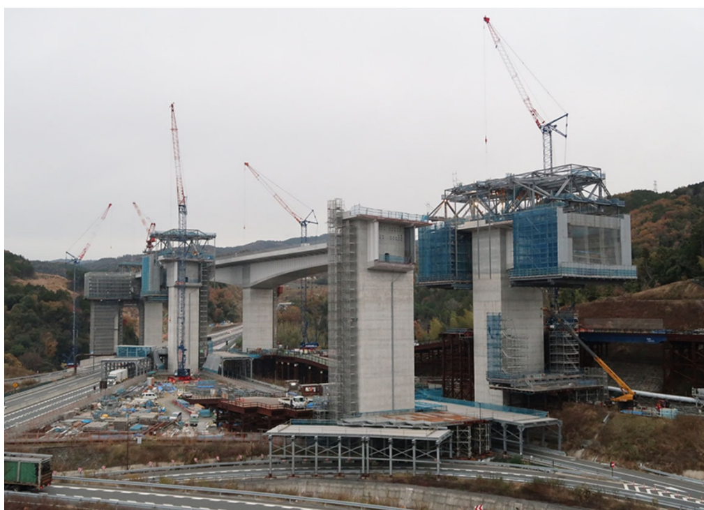
現場全景写真
