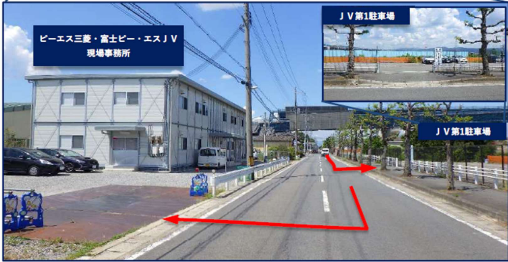
図 1.1 現場事務所および工事箇所
